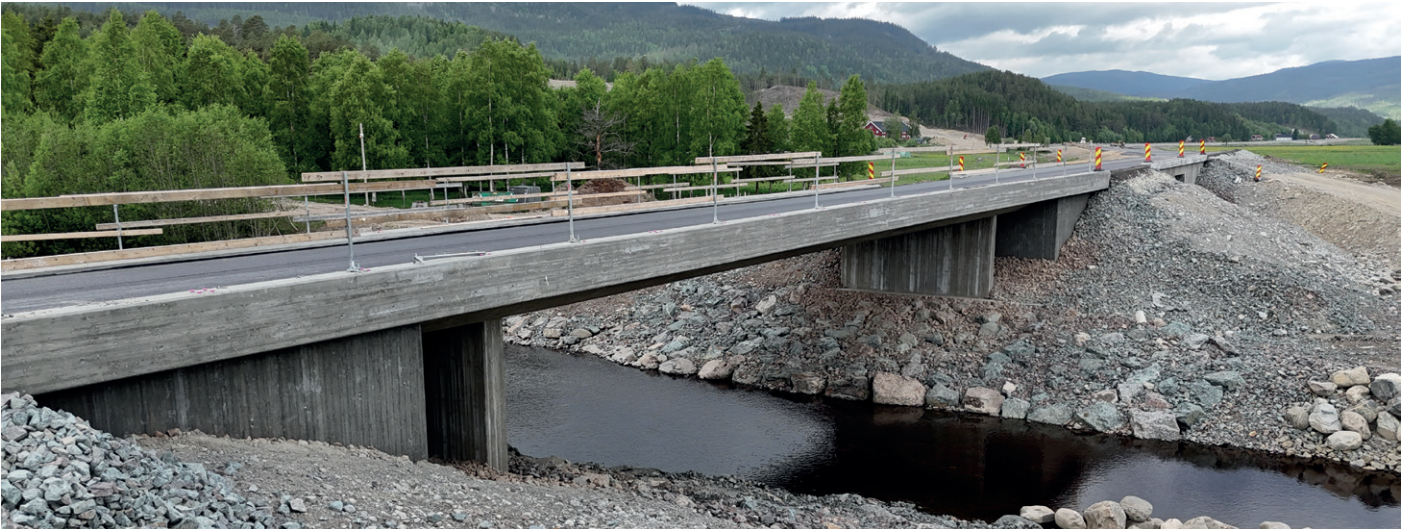
Denne nye brua, på rundt 30 meter, går over elva Rogna. Den var krevende å fundamentere og måtte peles ned til 35 meter.
