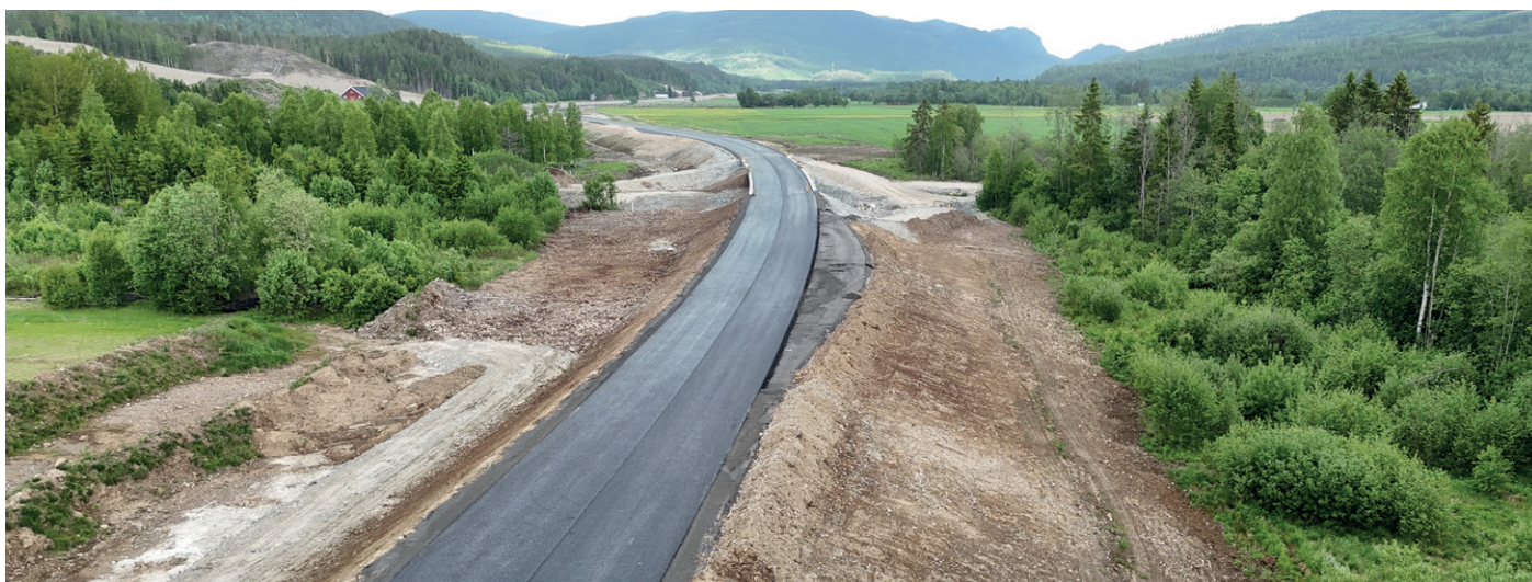
Den nye strekningen har fått 9,5 meters veibredde og fartsgrense på 80 km/t. Mesteparten av den gamle strekningen hadde 60 km/t som fartsgrense. Foto: Statens vegvesen
